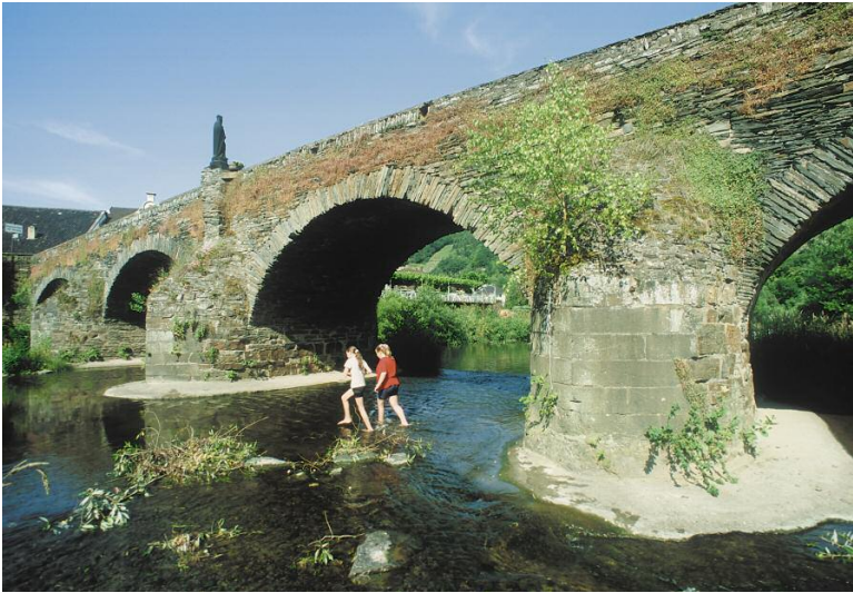
Der älteste noch bestehende Übergang über die Ahr: Nepomukbrücke in Rech
